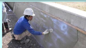
老朽化した水路壁のコーティング
