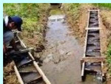
水田魚道の設置
