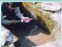
水路のひび割れ補修
