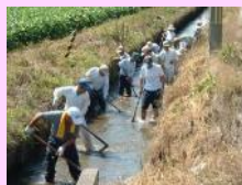
水路の泥上げ
