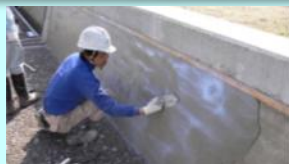
老朽化した水路壁のコーティング
