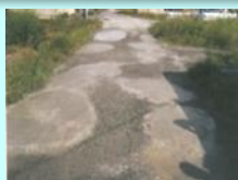
農道の窪みの補修
