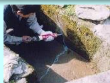
水路のひび割れ補修
