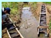
水田魚道の設置
