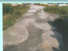
農道の窪みの補修
