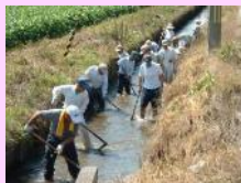
水路の泥上げ
