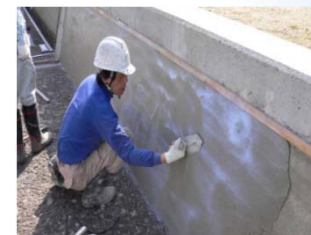
老朽化した水路壁のコーティング
