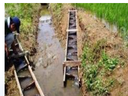
水田魚道の設置
