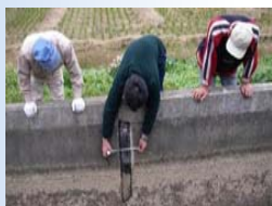
施設の機能診断
